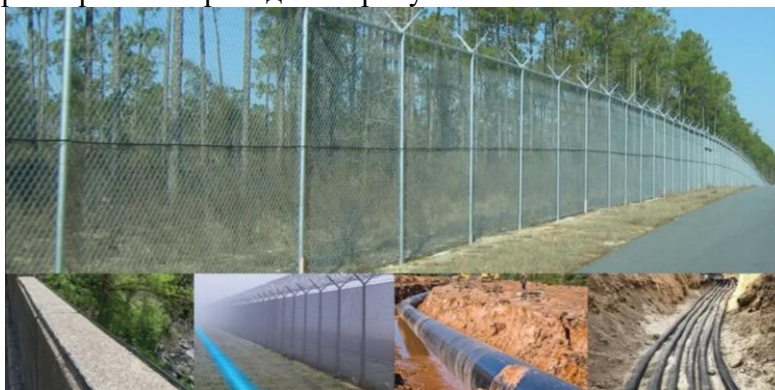
Рисунок 2. – Различные способы размещения сенсоров волоконно-оптической системы охраны
